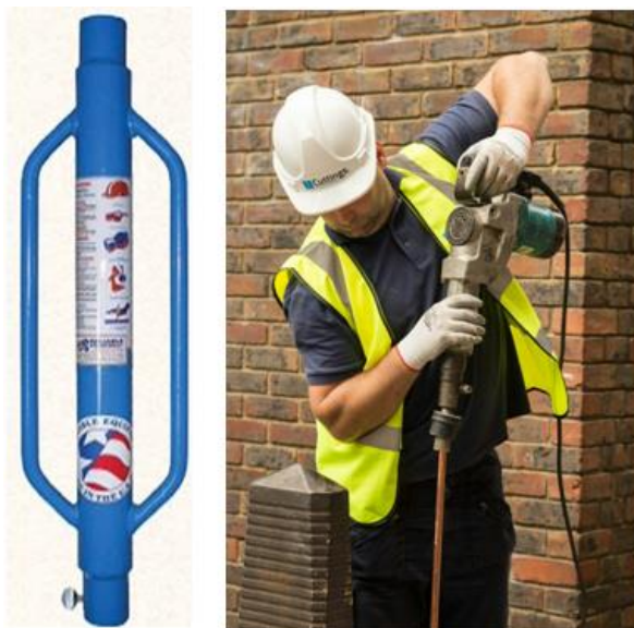
شکل (۲-۴): دو نمونه چکش مخصوص کوبیدن میله (سمت راست چکش برقی، سمت چپ، چکش دستی لوله‌ای)
